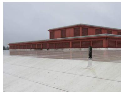
PHOTO: UPPER CLERESTORY ORIGINAL WOOD LOUVERS TO REMAIN TYP, EXISTING CONDITION
