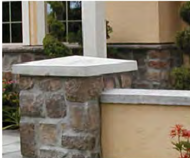
6 PRECAST CONC. CAP SCALE:
